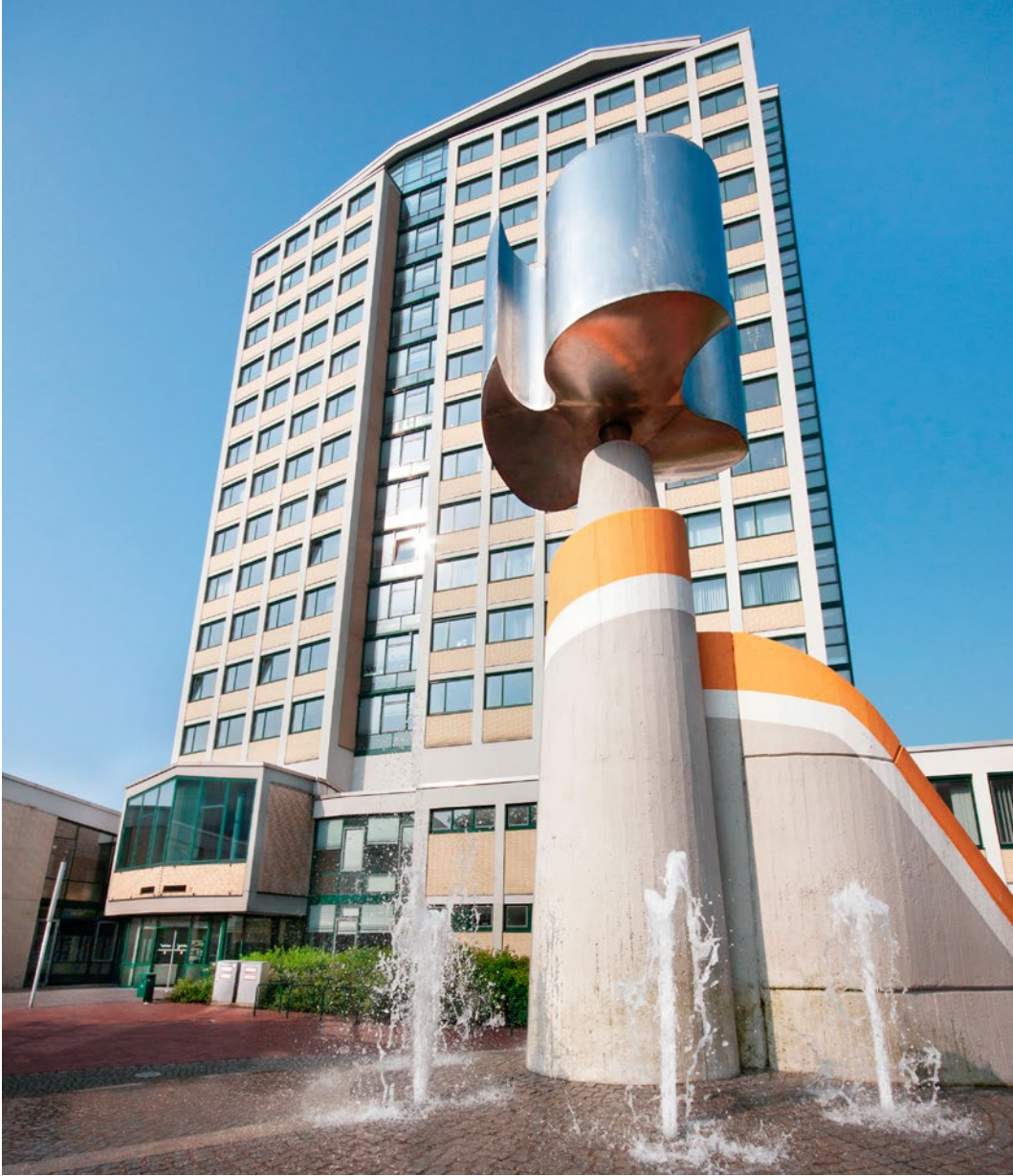
Im Rathaus Lünen sind 250 smarte Heizkörperthermostate verbaut.
