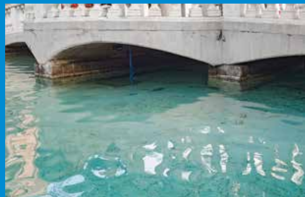
Pegelstandssensoren an verschiedenen Stellen im Europa-Park.
