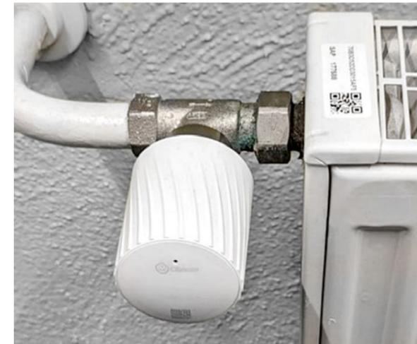
Das smarte Heizkörperthermostat steuert automatisch das Heizungsventil.
